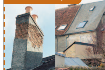
Chevrons débordants, tuiles de rive, jouées en tuiles ne sont pas adaptés à cette belle lucarne en pierre.
