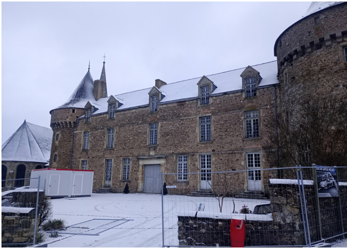
8 janvier : début de chantier
