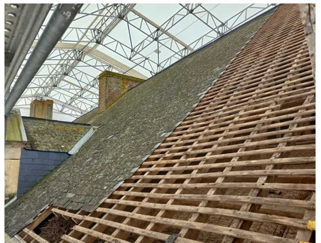
22 février : début de dépose de la couverture
