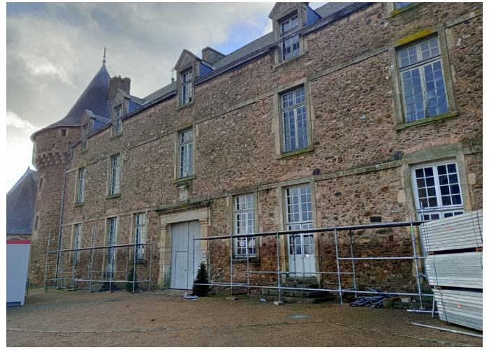
17 janvier : début du montage de l'échafaudage
