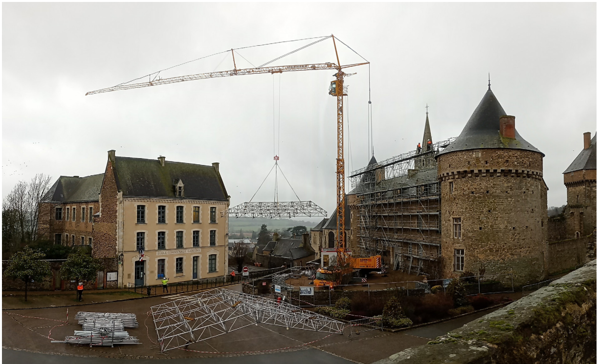
7 février : montage de l'échafaudage parapluie
