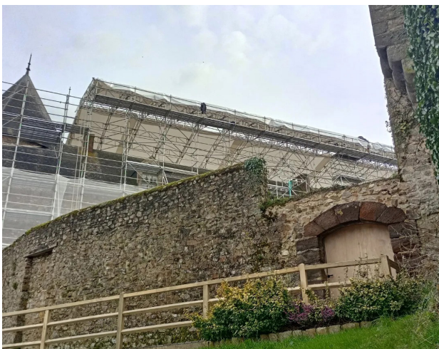
15 février : Echafaudage en cours de bâchage
